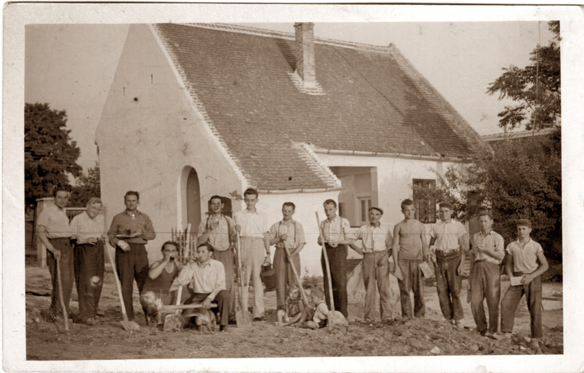
Az Egészségház építése 1958. évben
